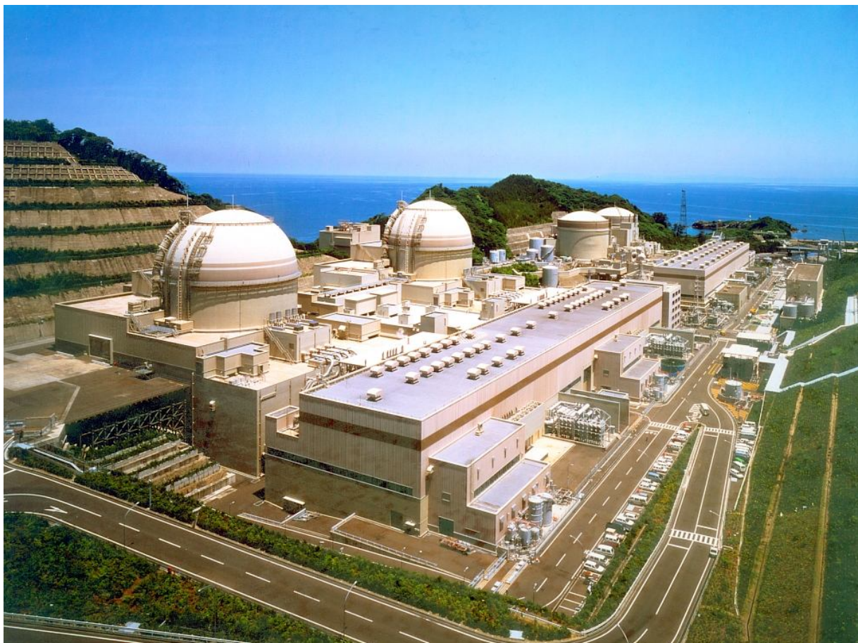
Rys. 4.12 Obudowy bezpieczeństwa (w kształcie kopuły) w elektrowni jądrowej Ohi w Japonii. (fot. Kansai Electric Power Co., źródło: IAEA)
